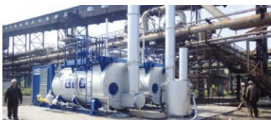
Installation clef en main de 2 chaudières de 6t/h
