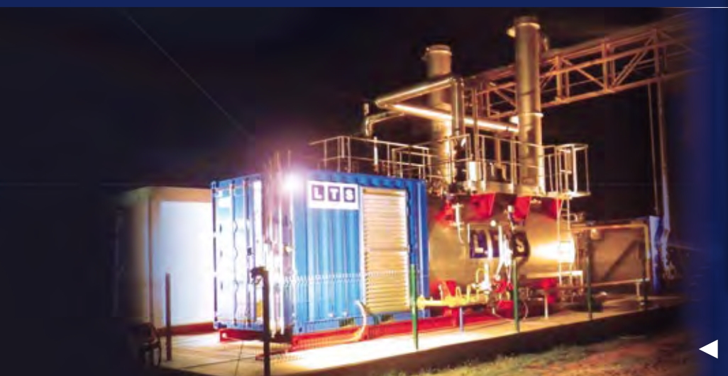
Vue sur l'installation LTS composée de 2 chaudières et d'une bache alimentaire
