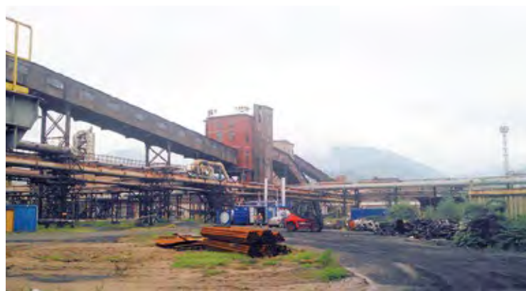
Vue sur l'installation LTS de 2 chaudières de 6t/h + bache alimentaire
